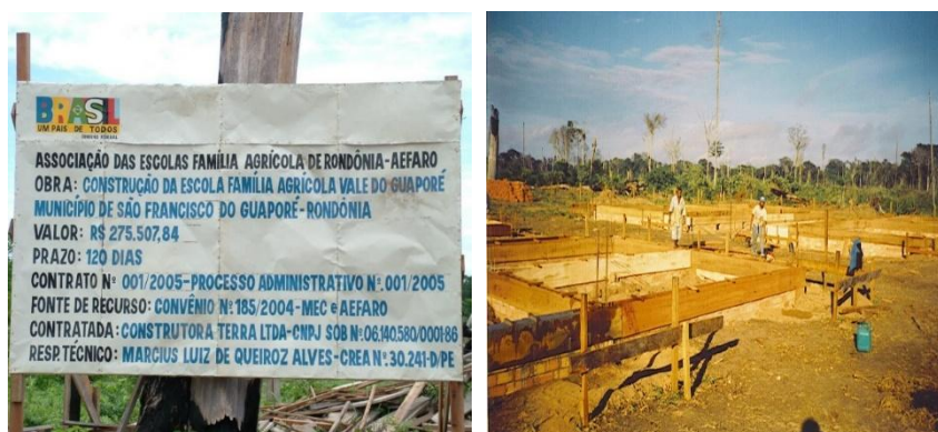
Figura 1 e 2 - Início da Construção.
