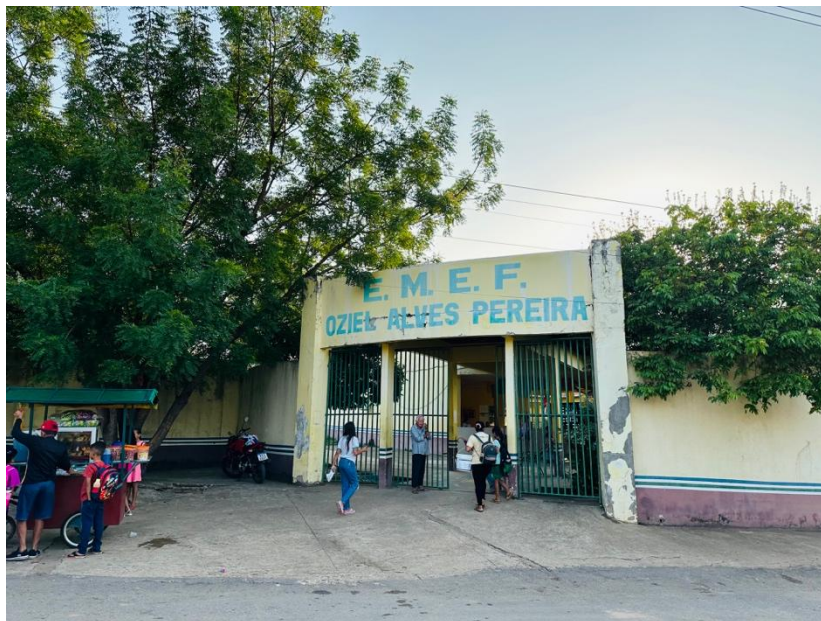
Figura 01: Fachada da Escola Oziel Alves Pereira.
