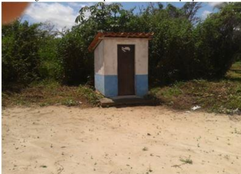
Figura 2 - Banheiro na parte externa da escola pesquisada.
