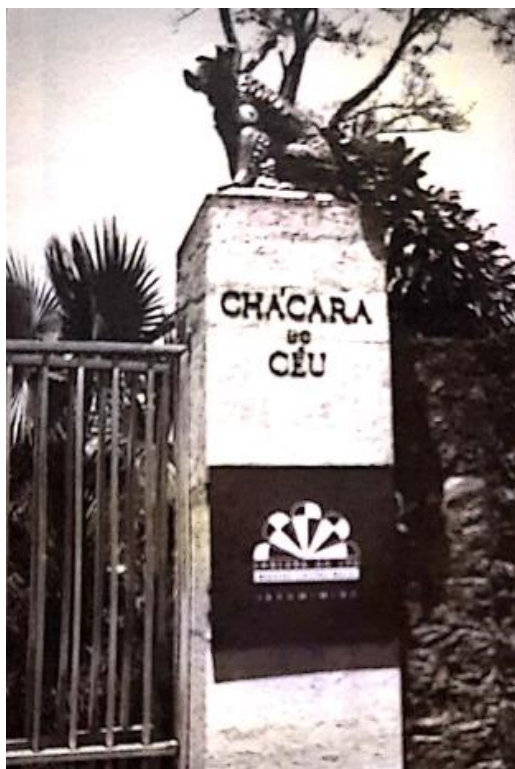
Figura 3: Fotografia da fachada do Museu Chácara do Céu Fonte: Garcia (2018, p. 14).
