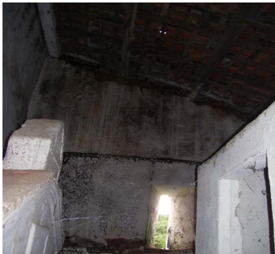
Imagem 5 - Câmara onde estão os túmulos parietais; detalhe da seteira ao fundo.
