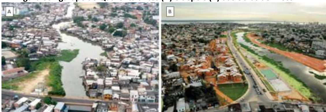
Figura 06. Igarapé do Quarenta antes (A) e depois (B) das obras do Prosamim.
