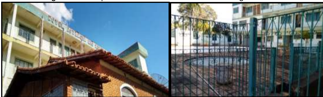
Figura 10: Vista parcial do hotel Estância Rio Pardo em Águas de Santa Bárbara
