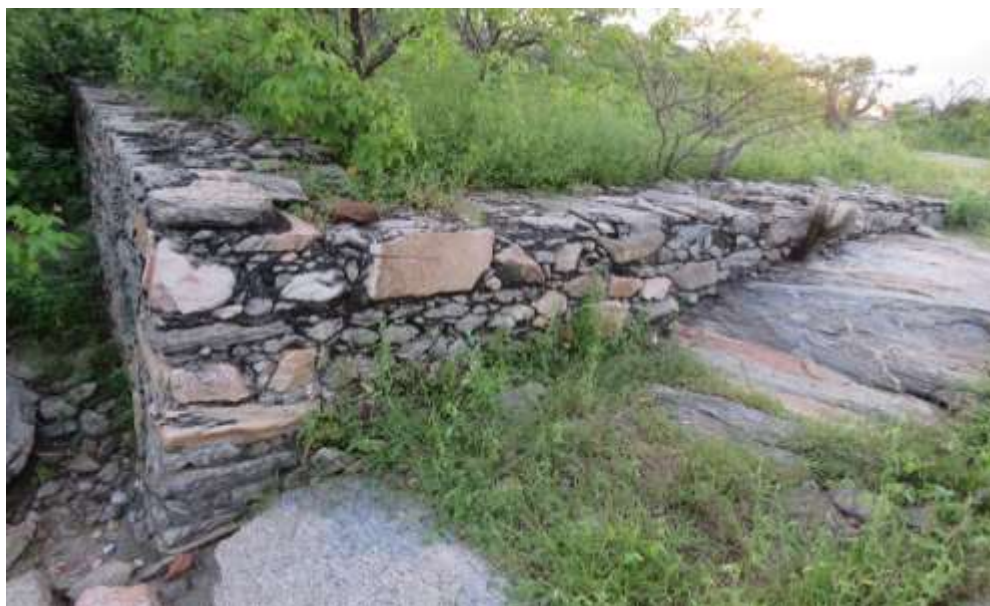
Figura 2 - Casa-Forte do Cuó, no território de Caicó
