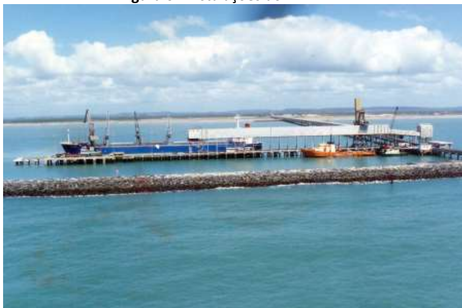
Figura 6 - Instalações do TMIB.
