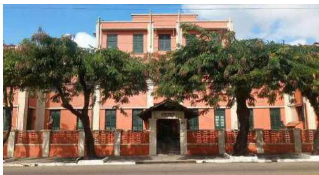
Figura 8- Fachada da Associação da Pia União do Pão de Santo Antônio (Casa Pão de Santo Antonio)
