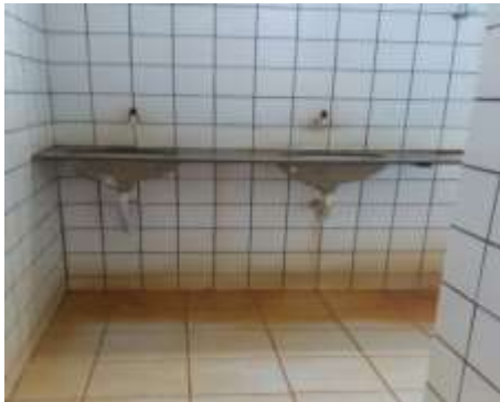
Foto 9. Parte interna do banheiro feminino.
