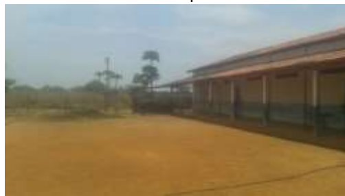
Foto 4. Corredor lateral esquerdo da escola.
