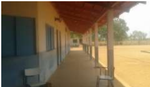
Foto 3. Corredor lateral direito da escola.
