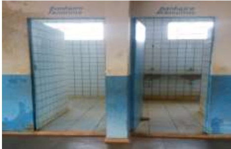
Foto 7. Entradas principais dos banheiros da escola.
