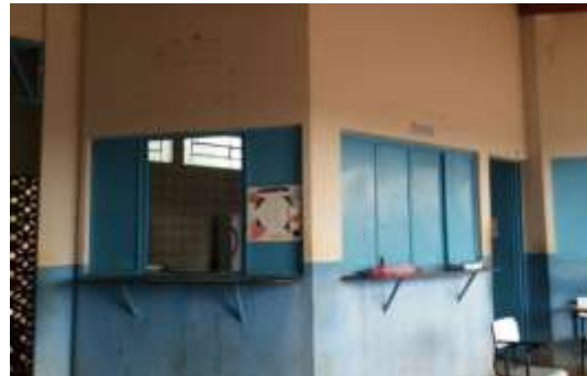
Foto 10. Parte externa da cantina da escola.
