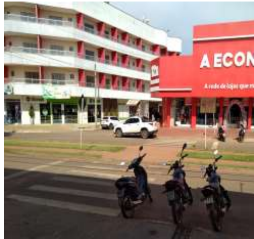
Figura 7 - Faixa sem acessibilidade
