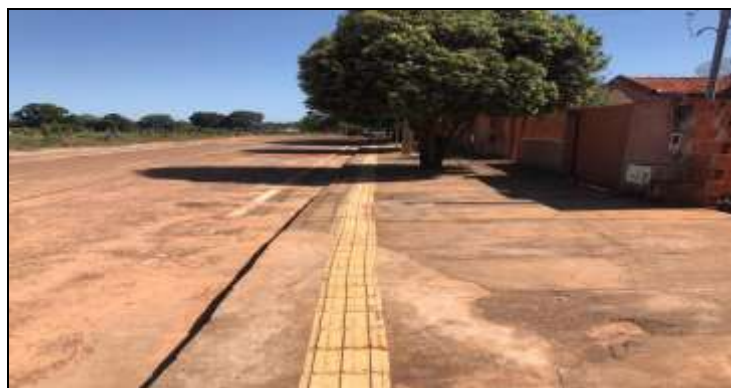
Figura 6 - Calçada com Acessibilidade.
