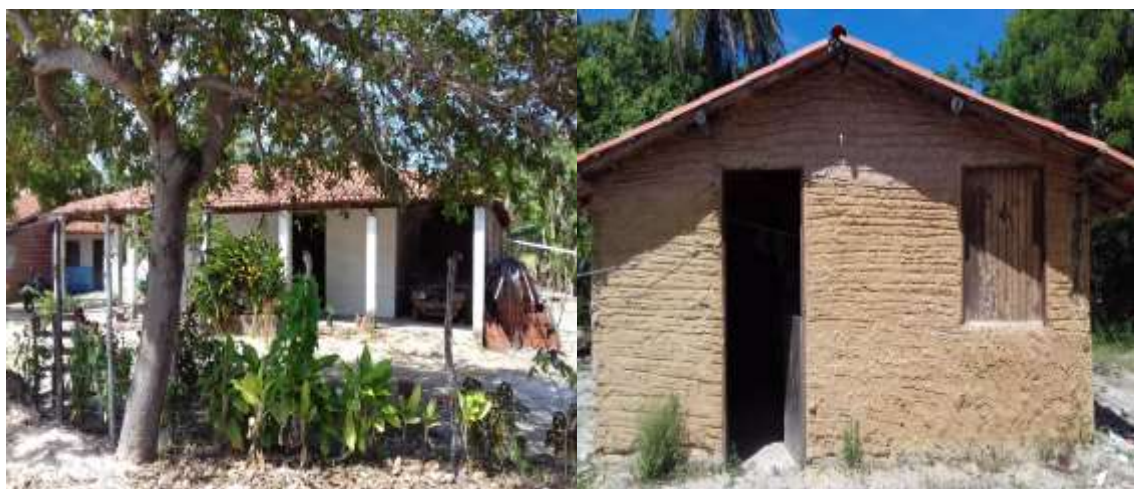
Figuras 2 e 3 – Casas da TI Lagoa da Encantada
