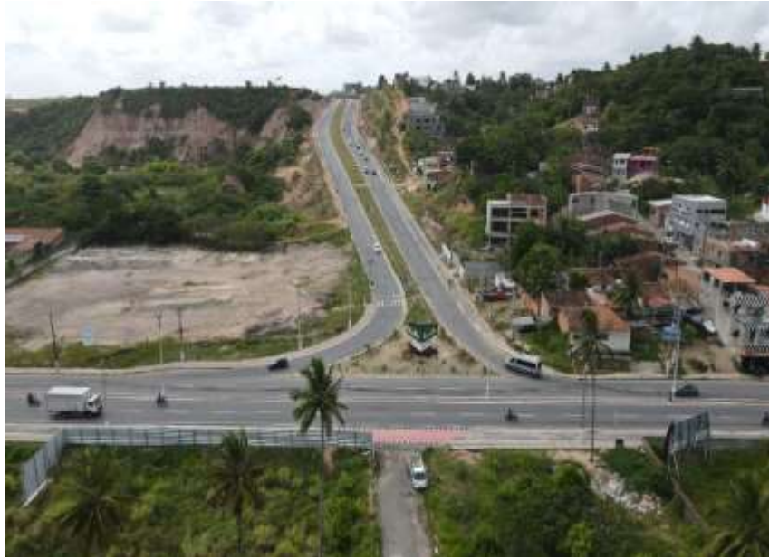
Figura 2 – Rota do mar no início da Rodovia AL-101 Norte
