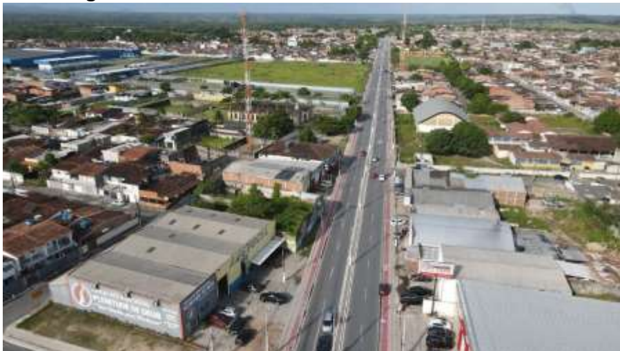
Figura 4 – Vista aérea da avenida Cachoeira do Meirim
