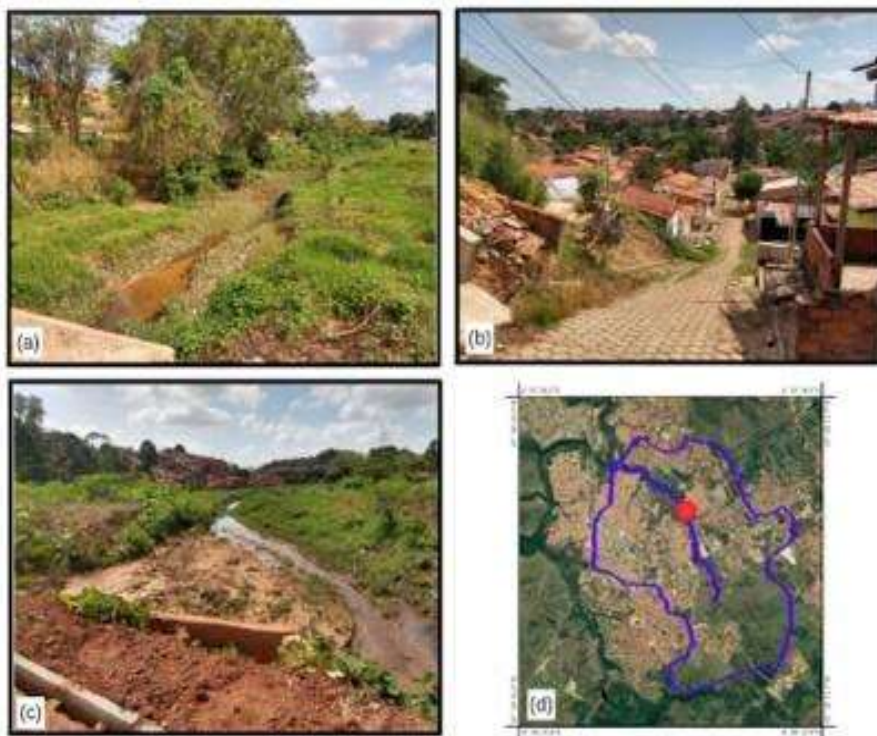
Figura 8 - Área de “Alto Risco Hidrológico” entre os bairros Vila Tancredo e Vila Ipiranga.
