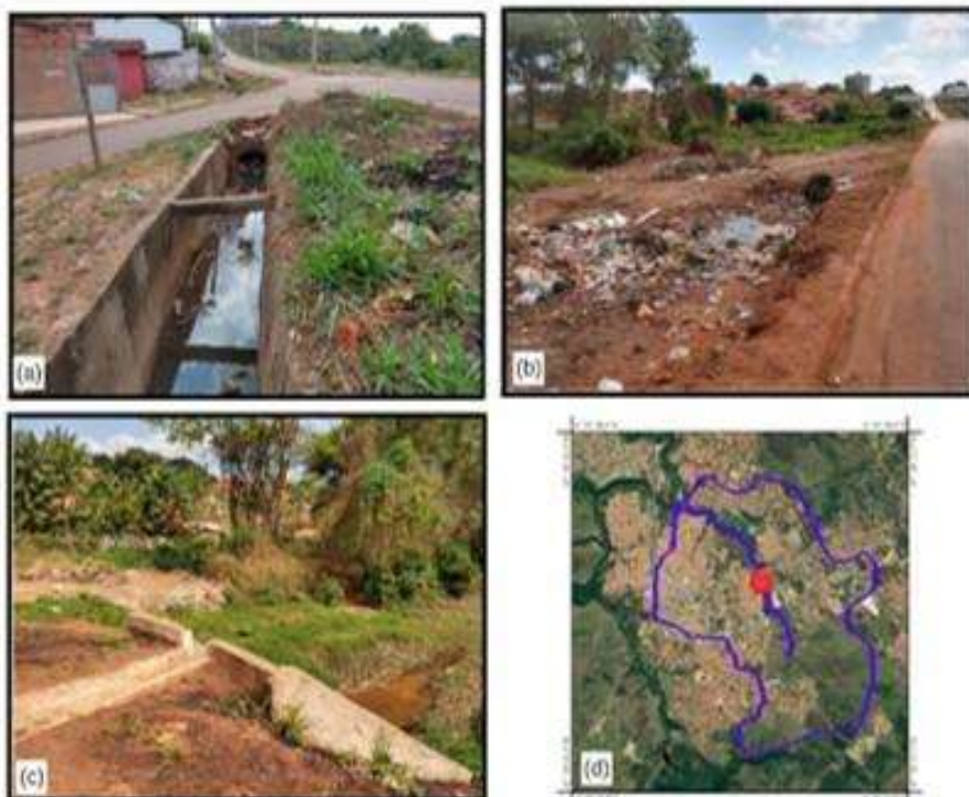
Figura 13 - Área “Alto Risco Sanitário” em APP entre os bairros Vila Tancredo e Vila Ipiranga.
