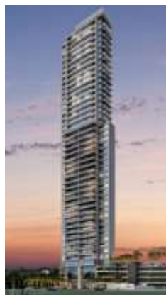
Figura 31 - Palmas: edifício Comodoro, na Orla 14
