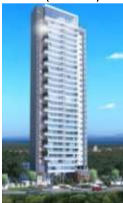
Figura 30 - Palmas: edifício Suprême Du Parc, na ARSE 41 (404 Sul)
