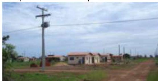
Figura 16 - Palmas: loteamento Jardim Taquari na área de expansão urbana sul
