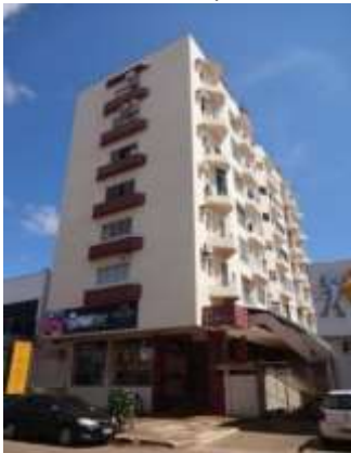
Figura 27 - Palmas: edifício Palmas I, na ACNE 1 (104 Norte)
