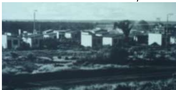
Figura 10 - Palmas: vista parcial do loteamento Jardim Aurenny I
