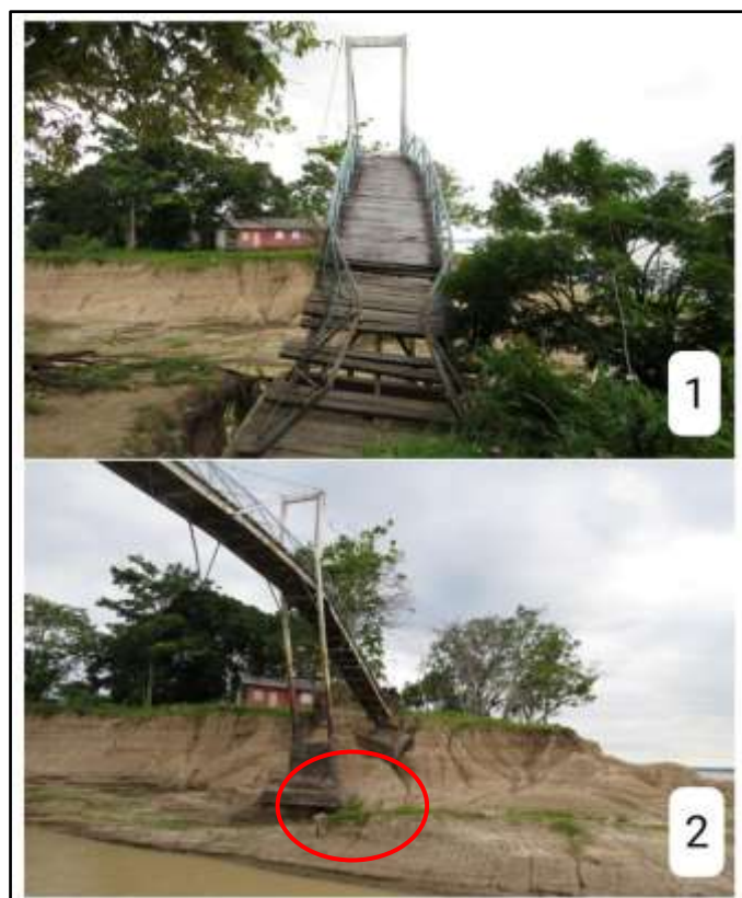
Figura 8: Ponte sobre o furo do Cainamã com sua base de apoio comprometida pela erosão de margem (terras caídas)
