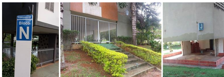
FIGURA 6 – Irregularidades: pilotis cercado, cercas nas entradas, construções em pilotis.
