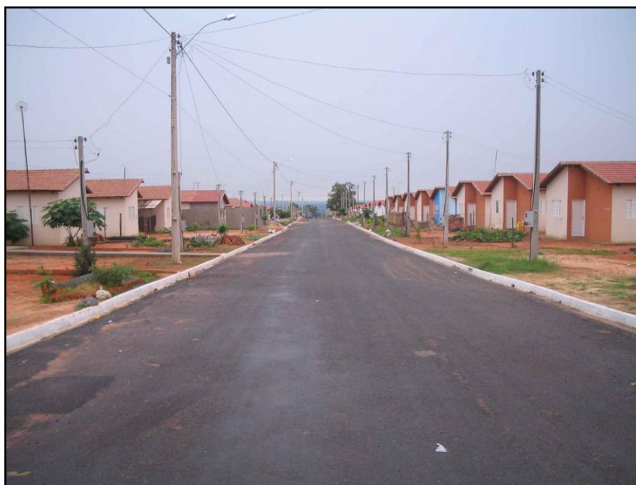
Figura 2 – Foto mostrando a ausência de calçadas nas residências.
