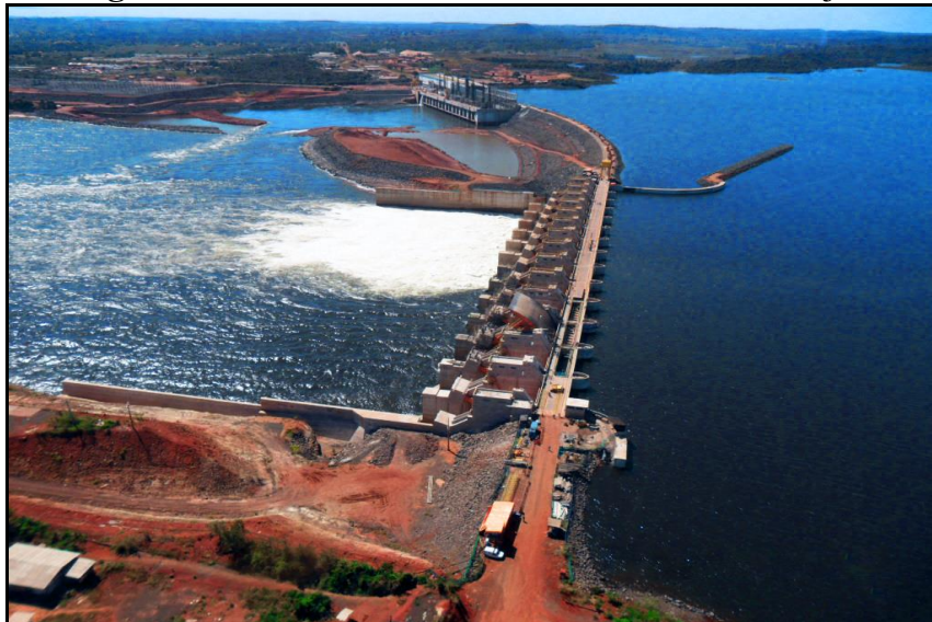
Figura nº 1: UHE/Estreito em sua fase de construção
