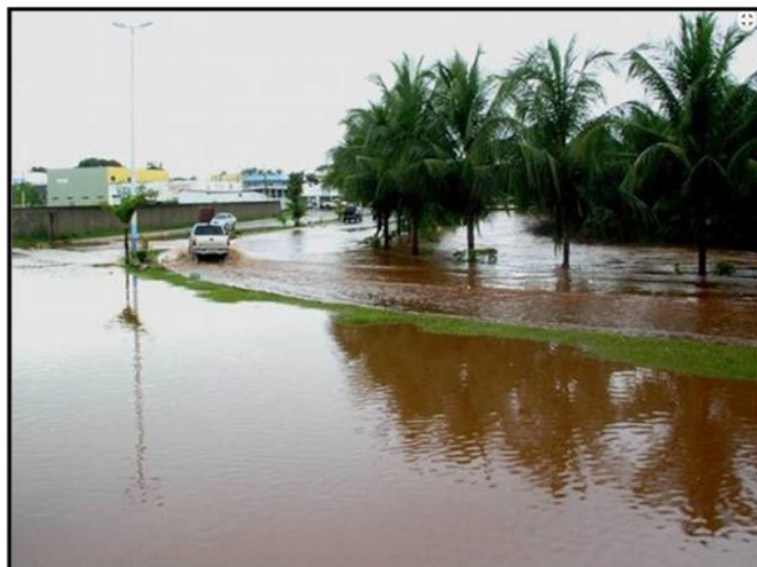
Figura 2. Córrego Neblina transborda após forte chuva alagando a Avenida Neblina
