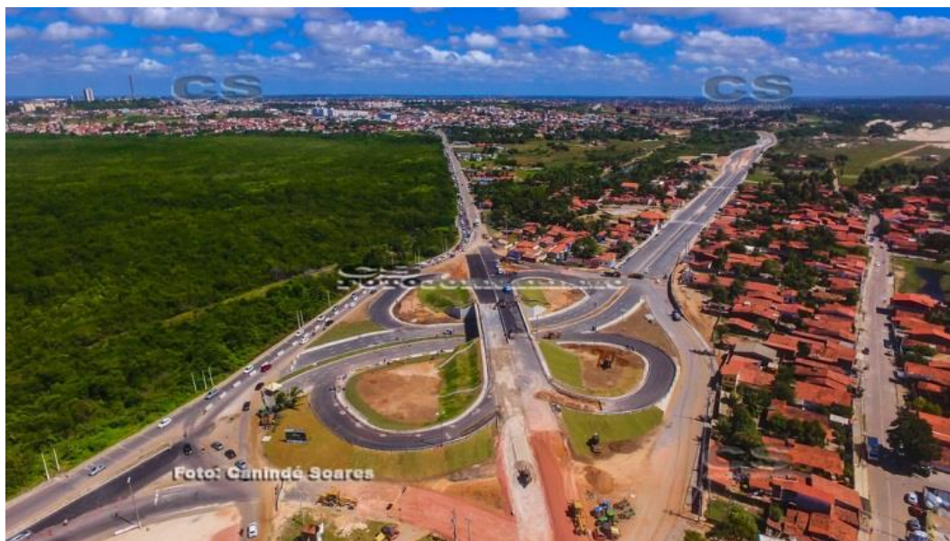
Figura 4 - Obras do Pró-Transporte
